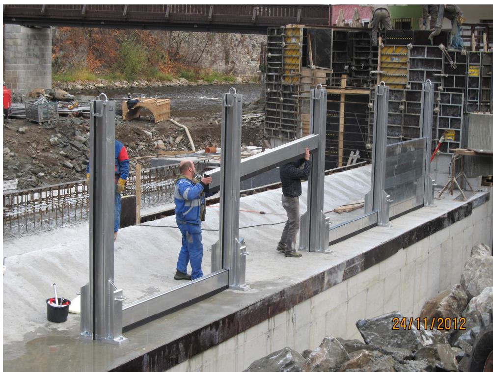
Montáž provizorního hrazení při stavbě
