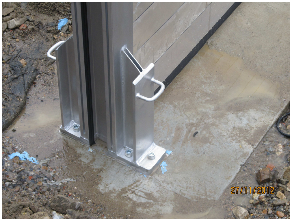
Detail provizorního hrazení
