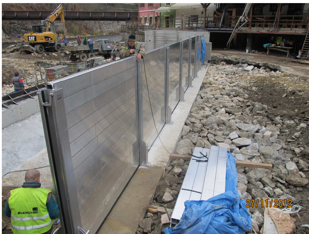
Provizorní hrazení při stavbě jezu
