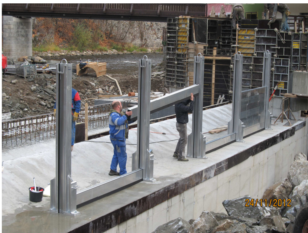
Montáž provizorního hrazení při stavbě
