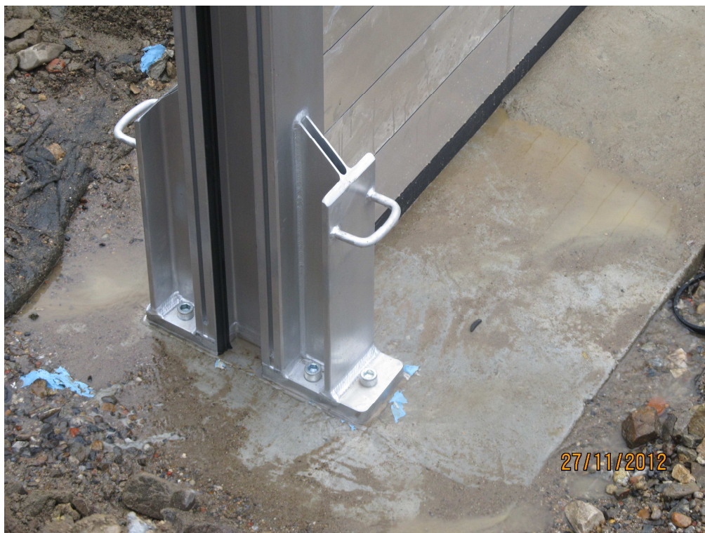
Detail provizorního hrazení
